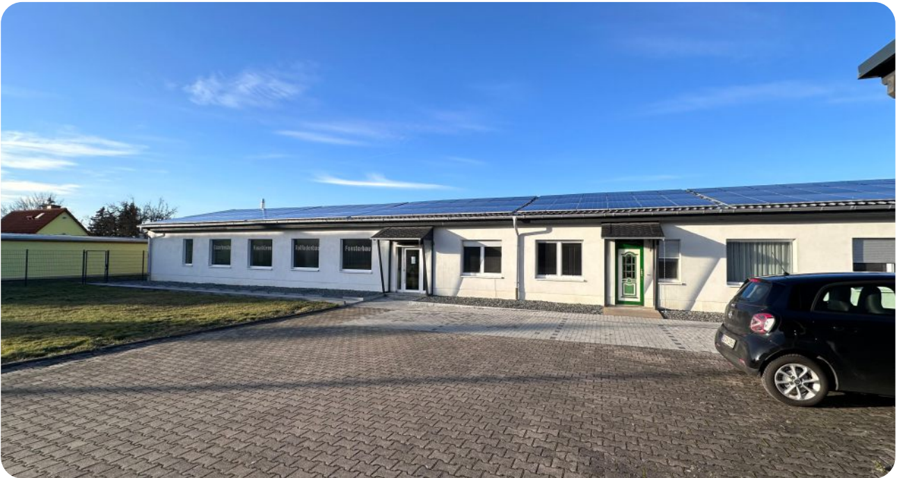
Ansicht von Strasse
