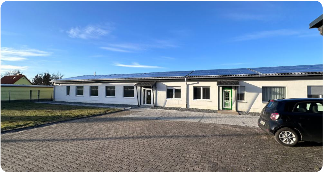
Ansicht von Strasse
