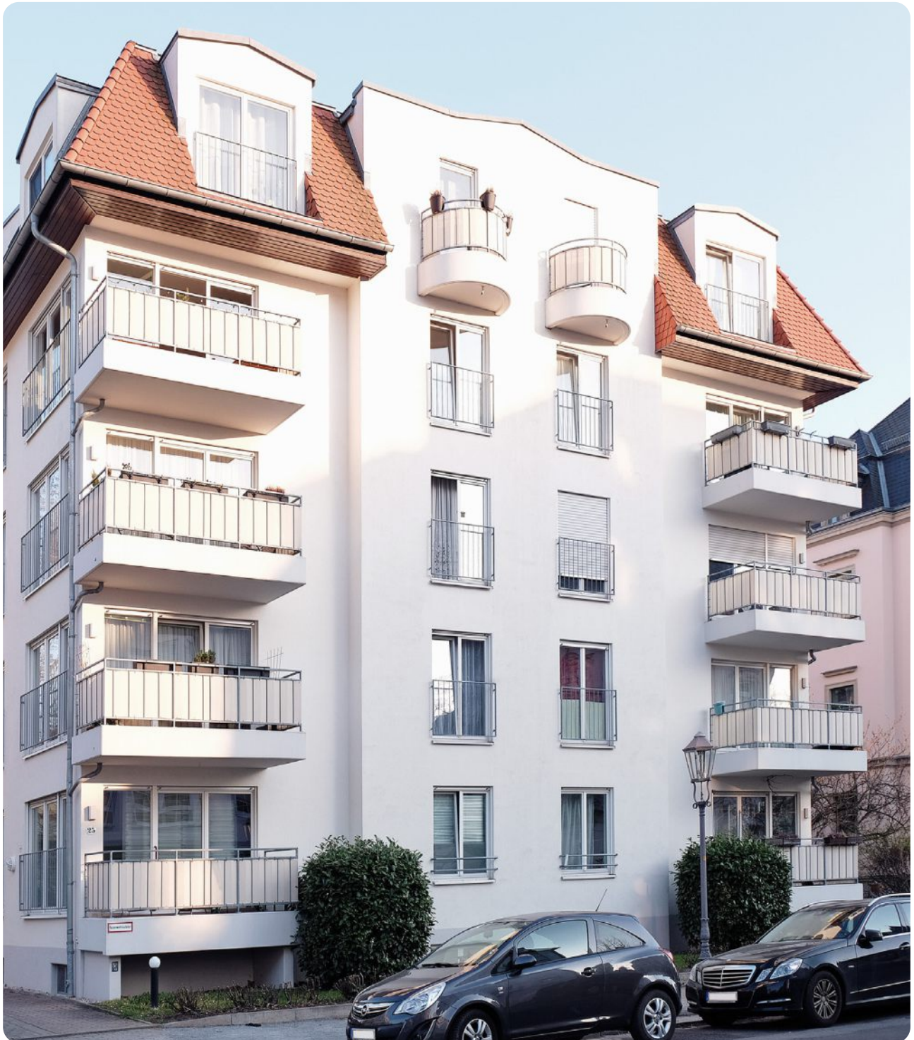
Aussenansicht Haus und Balkone
