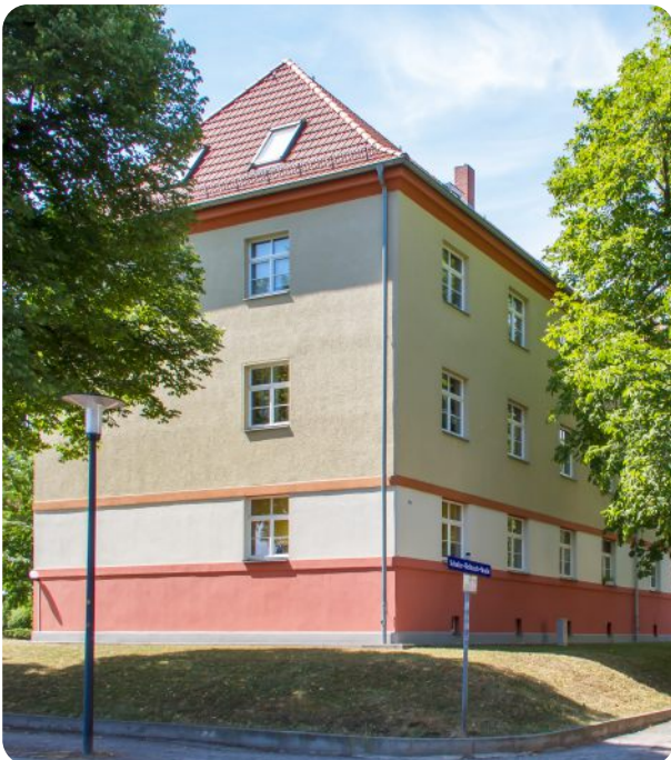
Aussenansicht von Straße
