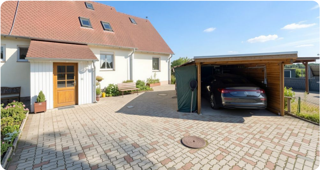
Zufahrt und Carport
